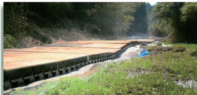
【施工完成】 敷鉄板で養生
